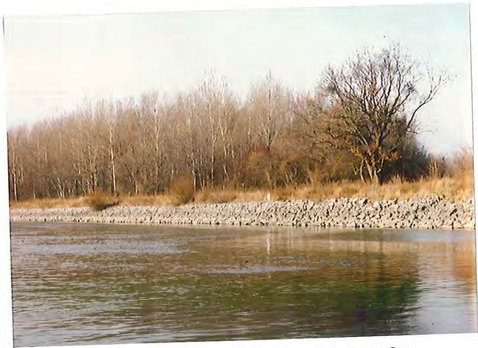
Abb. 37: Blocksteinwurf am Donauufer
