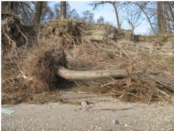
Erosion am Gehölzsaum
