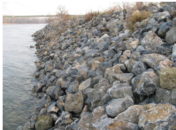
verbautes Ufer: strukturarme Blockwurfschüttung (rechtes Ufer bei Bad Deutsch Altenburg)
