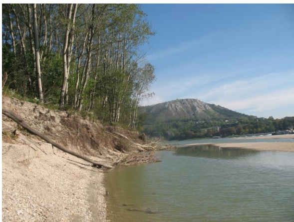
Erosionskante hinter vorgelagerter Schotterinsel, Stillwasserbereich am Böschungsfuß bei hohem Wasserstand
