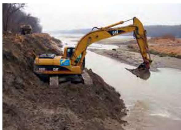
Die Nationalpark-Gesellschaft begleitete die Baumaßnahmen bei Witzelsdorf fachlich.
