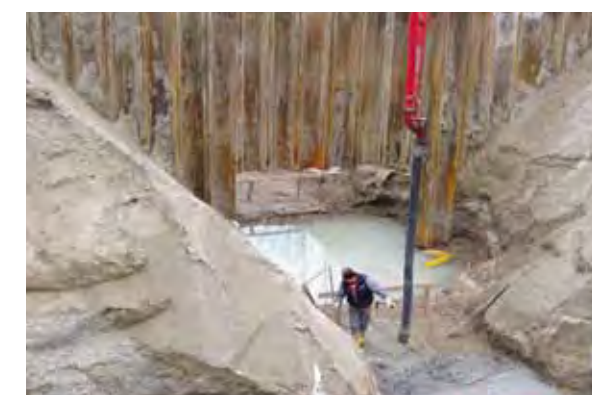
Die isolierten Abschnitte des Fadenbachs, einst ein Seitenarm der Donau, sollen wieder weitest möglich verbunden und mit Donauwasser versorgt werden.
