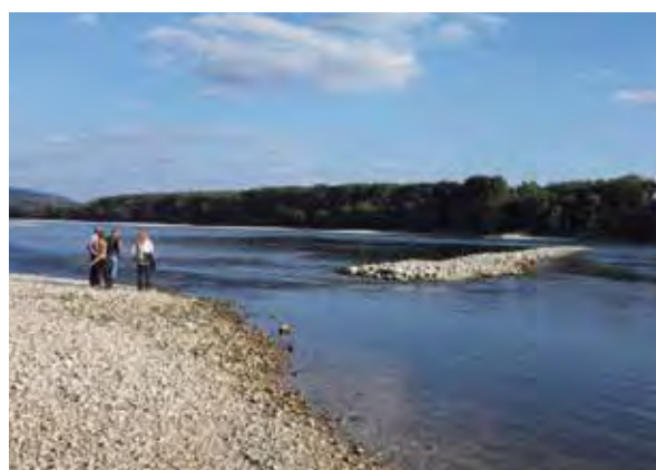
Pilotprojekt Witzelsdorf: Die neuartige Bühnen-Bauform ist der aktuellen Wasserspiegellage angepasst, zum Ufer geneigt und in Ufernähe abgesenkt.
