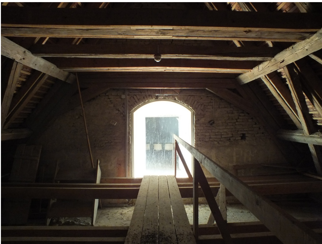
Abb. 8 Mit einer Glaswand wird das Innere des Dachbodens für BesucherInnen einsehbar
