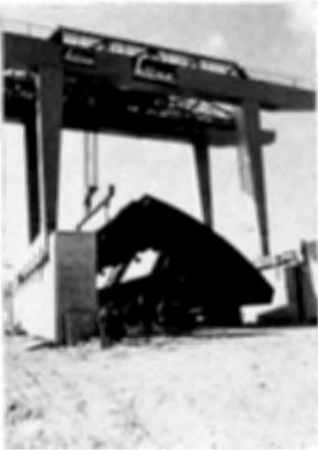
Abb. 16. Kraftwerk Altenwörth; Drucksegment in Montage
