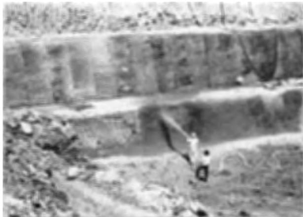
Abb. 10. Schlieraushub mit Spritzbetonsicherung
