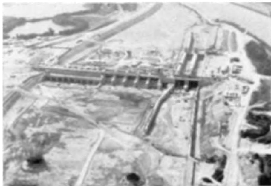
Abb. 11. Kraftwerk Abwinden-Asten; Bauzustand und Baugrube neben dem Strom (BMfLV, Zl. 13080/909-1.6./78)
