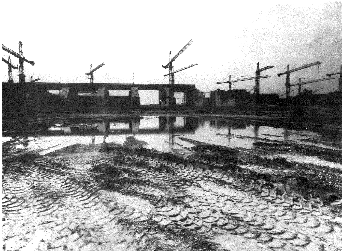
Kraftwerkbau Greifenstein flüßauf der Hauptstadt Wien.
