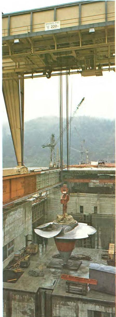
Montage eines Turbinenlaufrades, Kraftwerk Aschach
