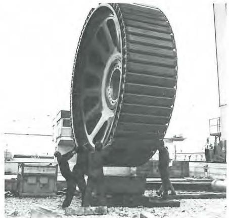
Generatorlaufrad (Rotor) vor dem Einbau
