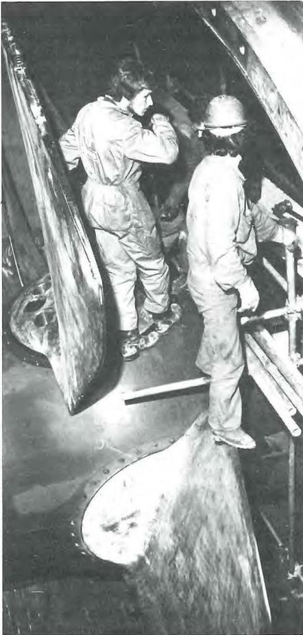
*Ein Turbinenlaufrad (Durchmesser 6 m) während der Montagearbeiten*
