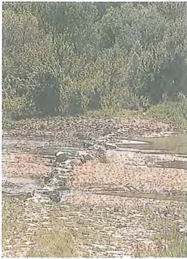
Die abgesenkte Traverse am Mitterhaufen (Haslau) soll den Wasserdurchzug verstärken.
