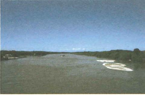
Zur Bereicherung der hart verbauten Donauufer wurde bei Orth das Kiesmaterial einer Furtenbaggerung zur Gestaltung einer Schotterinsel verwendet. Diese Struktur wurde ohne wasserbauliche Steinwurfsicherung aufgebaut und dem Fluss zur Überformung bzw. zum Abtrag überlassen werden. Die Finanzierung erfolgt im Rahmen des LIFE-Projektes.
