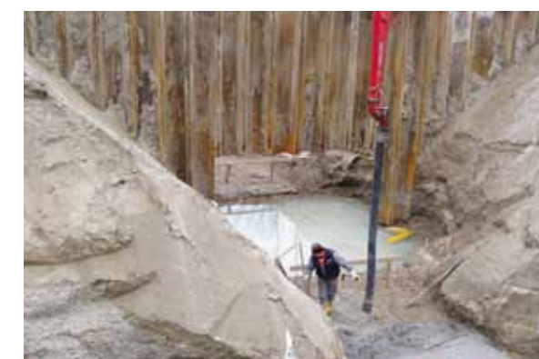
Die isolierten Abschnitte des Fadenbaches, einst ein Seitenarm der Donau, sollen wieder weitest möglich verbunden und mit Donauwasser versorgt werden.
