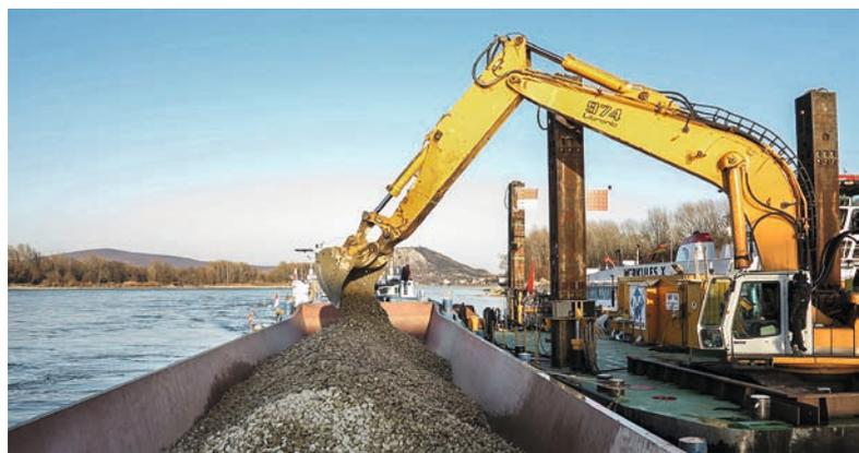
*Durch Geschiebemanagement – Rückführung von Material stromauf und Zugabe von größerem Kies – kann ein wesentlicher Beitrag zur Aufhaltung der Sohlerosion geleistet werden.*
