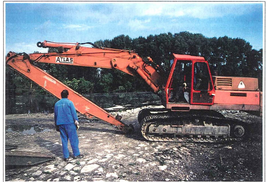
Foto 4: Flußbauliche Maßnahmen in Regelsbrunn (Foto Hausherr).
