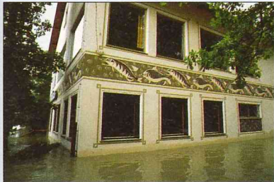
HOCHWASSER BEIM UFERHAUS ORTH
