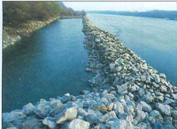
**Leitwerk** Regulierungsbauwerk aus Steinen, das parallel zur Strömung angelegt wird. Leitwerke lenken den Strom in eine bestimmte Richtung.
