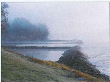
**Buhnen** Regulierungsbauten aus Steinen, die quer zur Stromrichtung angelegt werden. Sie bewirken eine Stromverengung und mehr Wassertiefe für die Schifffahrt.
