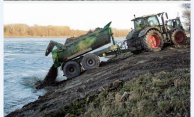
Die großen Mengen an Sand müssen maschinell entfernt werden.
