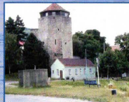
Der Wasserturm aus dem 13. Jahrhundert wird von späteren Zubauten befreit
