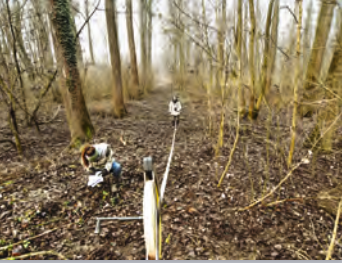
Vermessung einer Forststraßenquerung, die rückgebaut werden soll
