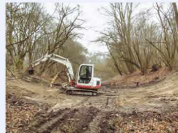
Wiederhergestellter Graben nach Rückbau einer Forststraßenquerung
