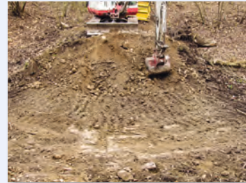
Vernetzung von Gräben mittels Bagger
