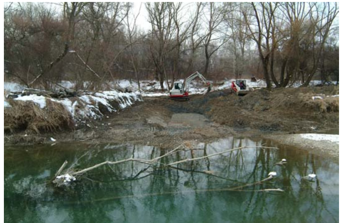
Traversenrückbau verbessert die Lebensraumsituation
