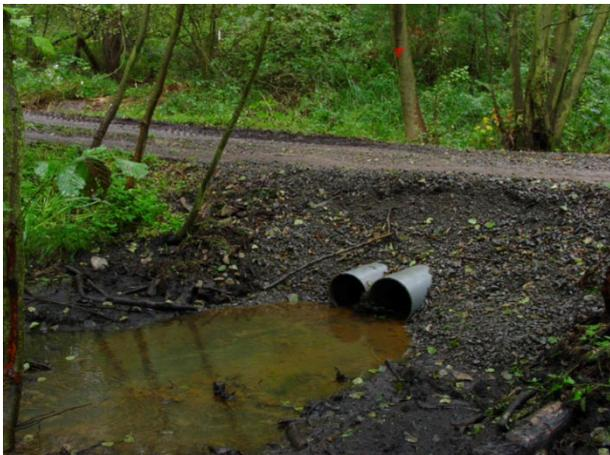
Nach dem Durchgang der Überschwemmungsdurchflüsse 2009 – 2010 überarbeitete man die Lösung im Kreuzungsbereich mit dem Waldweg durch Einbau von zwei Rohren mit einem Durchmesser von 30 cm und ihrer nachträglichen mehrfachen Verschüttung mit Bruchstein, auf dem der Straßenkörper liegt. Direkt in der Aufstiegshilfe wurde mit Hilfe einer wiederholten ichthyologischen Bestandserfassung das Vorkommen von 14 Fischarten bestätigt. Die durchgeführten ichthyologischen Analysen haben gezeigt,
