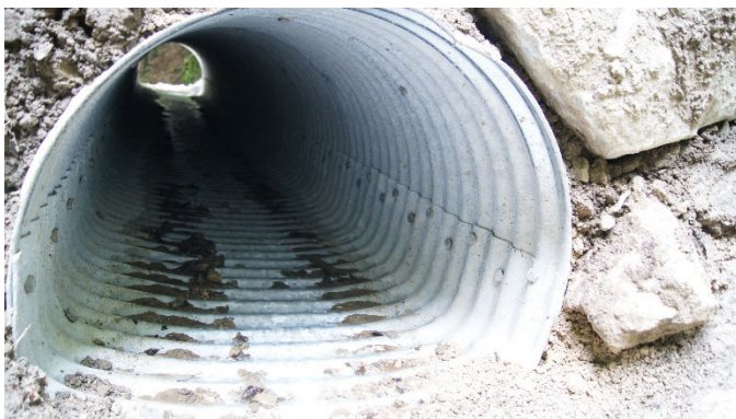
Abb.20: Beispiel für einen getauschten Rohrdurchlass © Bundesforste AG
