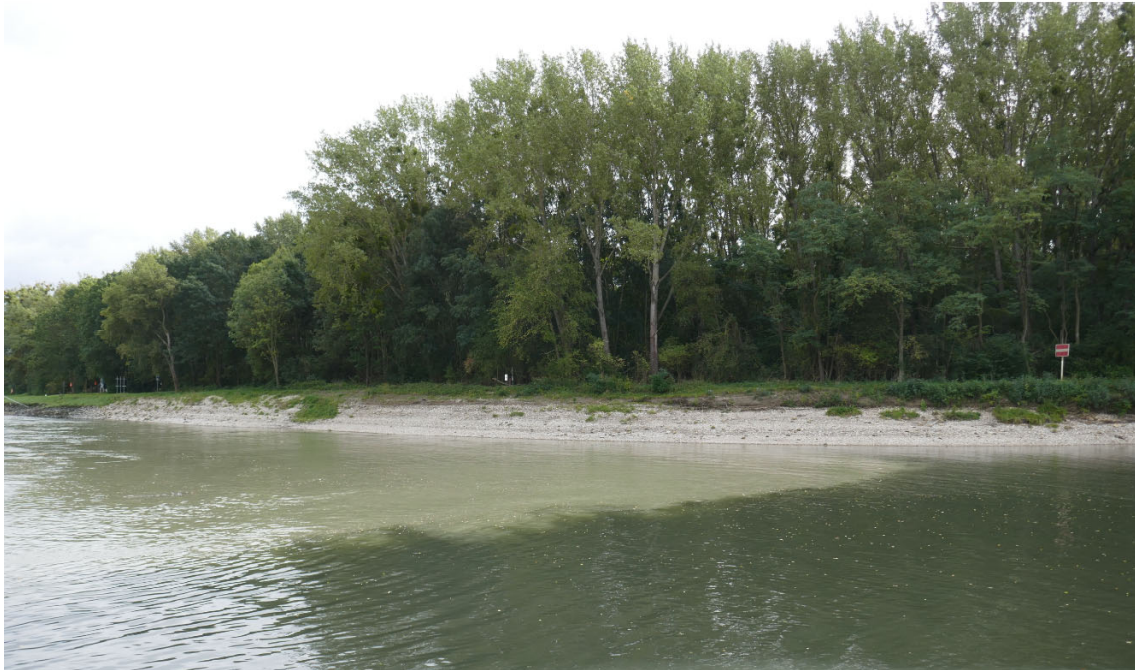
Abb.12: Die Fischamündung nach der Durchführung der Maßnahmen. Foto: Via Donau
