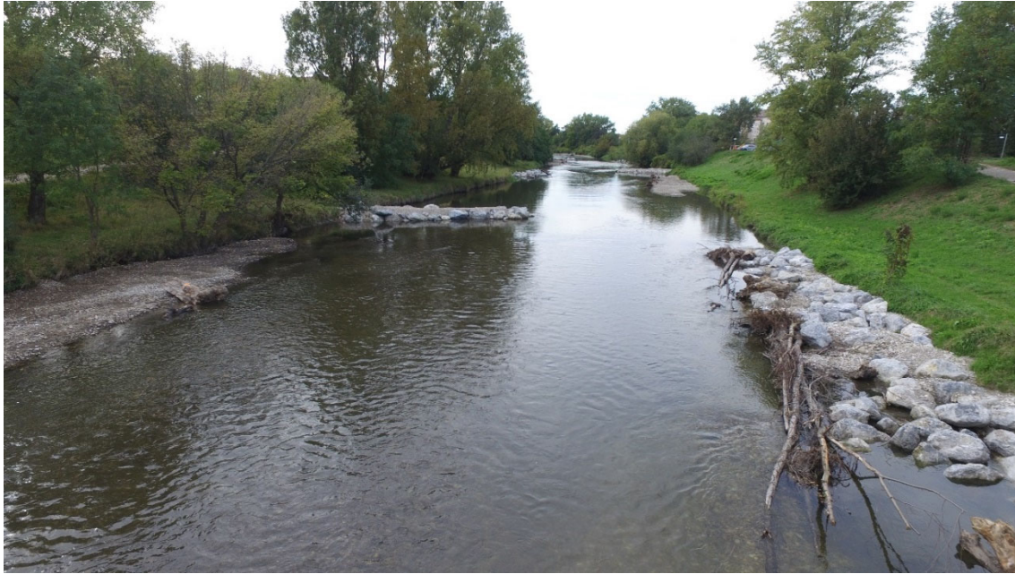
Abb.16: Die strukturverbessernden Maßnahmen an der Schwechat im Stadtgebiet © EZB
