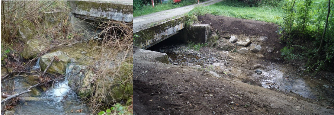
Abb.19: Strukturverbesserung Sohlrampe (Entfernung und Verbesserung mit Wasserbausteinen) vorher und nachher © Bundesforste AG
