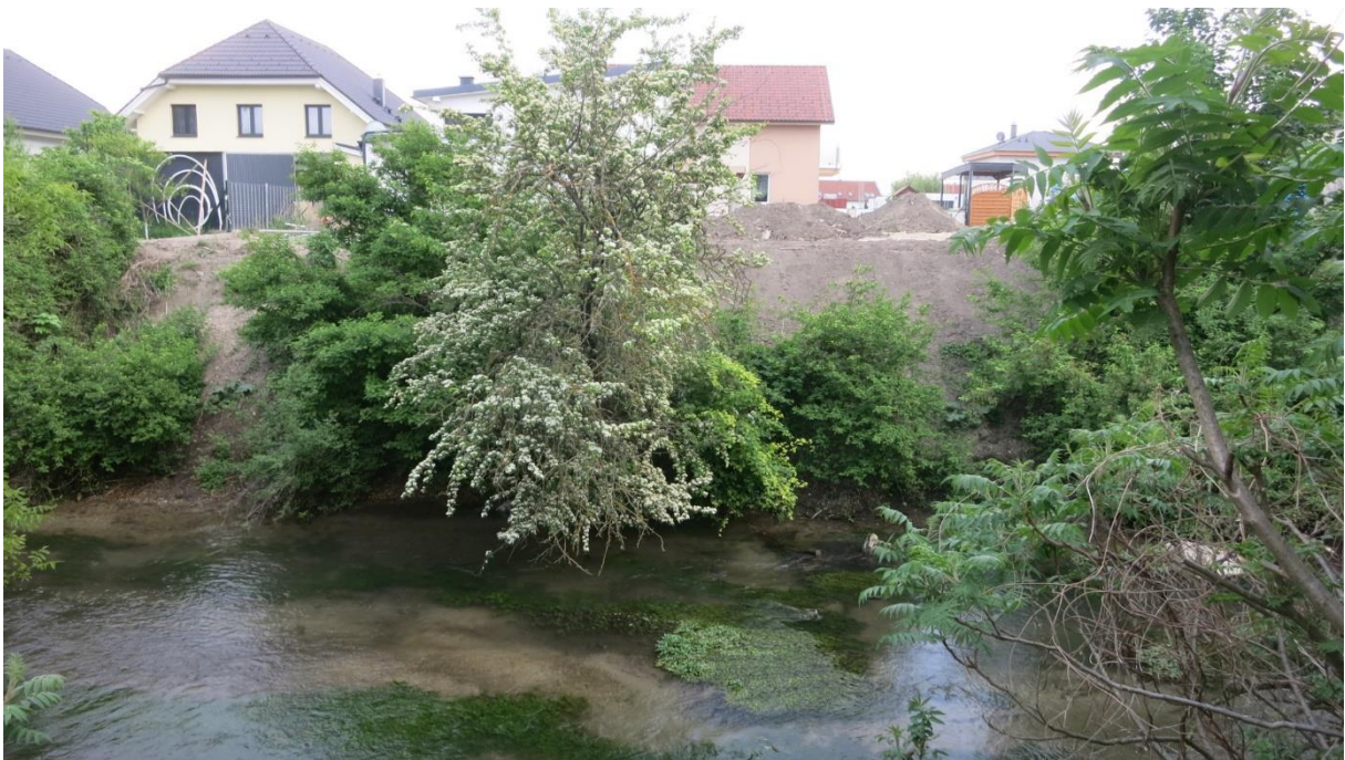
Foto 16: An der Fischa wurde in Abschnitt fi_107 im Zuge eines Hausbaus ein Erdwall am Ufer aufgeschüttet. Eine Strauchreihe an der Straßenseite und ein „Säubern“ der Wand könnte die Attraktivität für den Eisvogel steigern.
