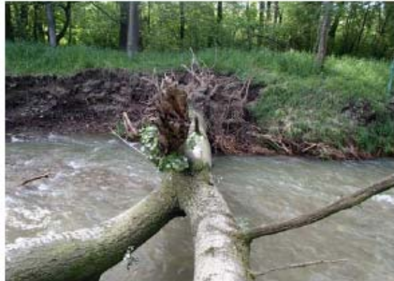
Sturzbaum mit Uferanriss. Wurzelstöcke sollten nach Möglichkeit als Strukturierungselement belassen werden, © ezb
