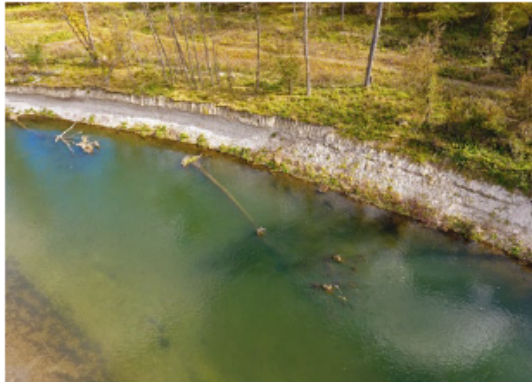
Uferanriss im Mündungsbereich der Traisen. Mögliche Erosionsflächen wurden dem Grundeigentümer abgelöst um Konflikte zu reduzieren, © Pock
