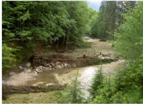
Sicherung stark beanspruchter Böschungsbereiche durch den Einbau von Raubäumen, © ezb
