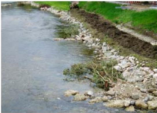
Ortsstrecken: Herstellung einer verzahnten Uferlinie mit Kurzbänken und Raubäumen, © ezb
