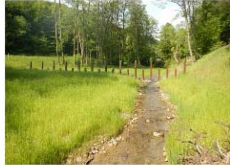
Mobilisiertes Wildholz stellt eine große Verklauungsgefahr für Brücken und Wehre dar. Wildholzrechen am Pöllerbach, © ezb
