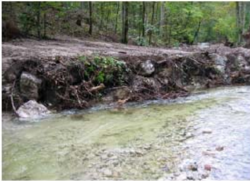
Ufersicherung durch Kombination von Steinwurf, Wurzelstöcken und Gehölzpflanzung. Toplitzbach, © ezb
