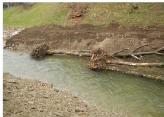
Mit Stahlseil (Erdanker) fixierte Raubäume, © ezb
