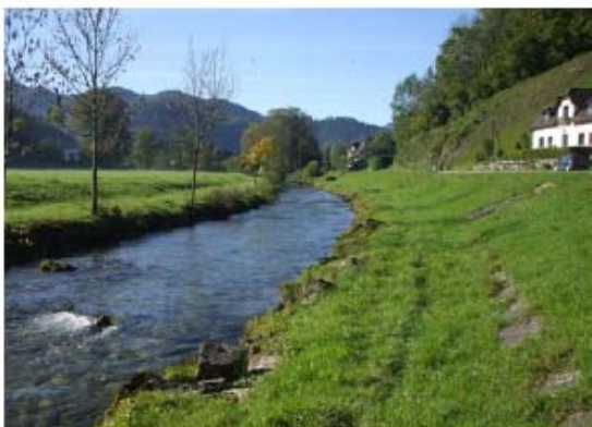
Gewässertypische Ufergestaltung an der Traisen bei Hohenberg. Zustand vor Maßnahme, © ezb
