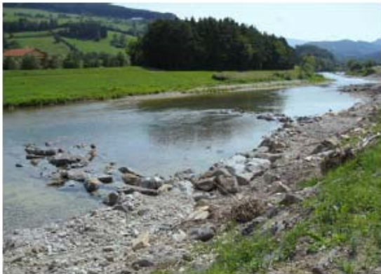
Ortsstrecken: Bühnen an der Traisen bei Wasenmühle, © ezb
