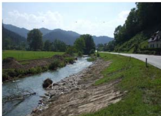
Zustand nach Aufweitung und Strukturierung. Ersatzpflanzung von Gehölzen an der Böschungsoberkante. Entfernte Gehölze wurden als Strukturierungselement eingebaut, © ezb
