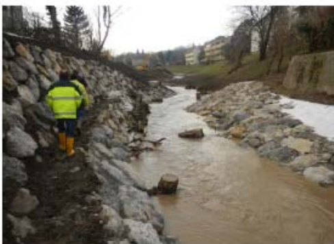
Blockwurf mit verankerten Totholzstrukturen in beengten Raumverhältnissen (Liesing, Wien, Brückenquerung), © ezb
