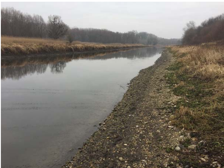
Abb. 3: Fischa flussab des Hochwassersperrbauwerks
