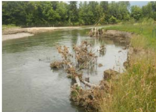
Mit Piloten befestigte Totholzstruktur zur Ufersicherung. Ybbs bei Hausmening, © ezb
