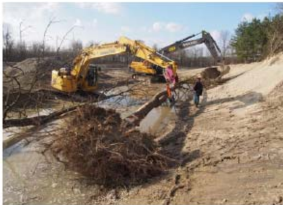
Raubäume. Befestigung durch Erdanker, © ezb
