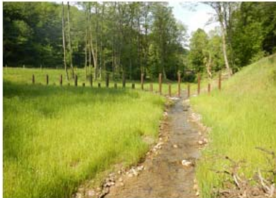
Mobilisiertes Wildholz stellt eine große Verklausungsgefahr für Brücken und Wehre dar. Wildholzrechen am Pöllerbach, © ezb
