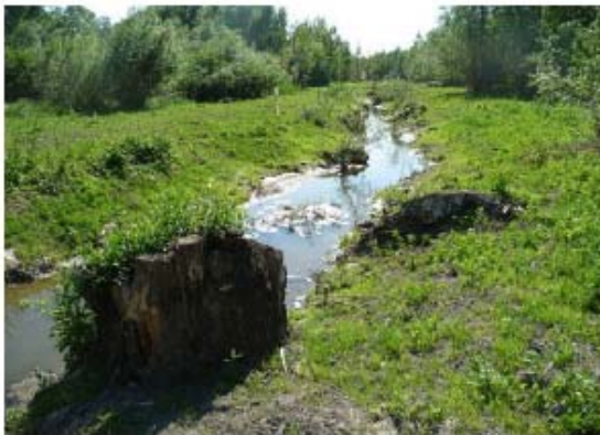
An der Böschungsoberkante versetzte Wurzelstöcke, © land. und.wasser
