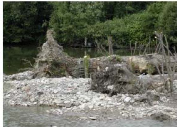
Mit Erdanker und Steckhölzern befestigte Holzstruktur, © ezb
