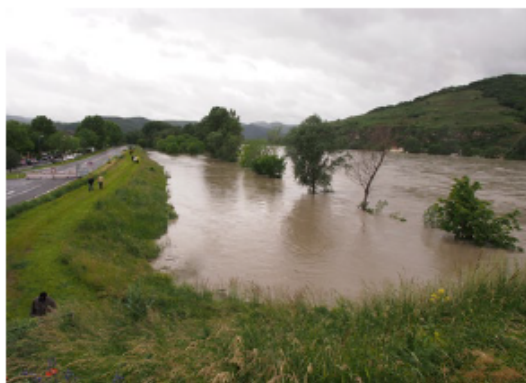
Längsdamm an der Donau bei Mautern, Hochwasser 2013, © ezb
