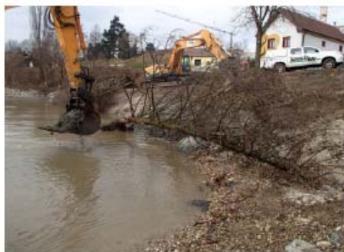
Einbau eines Raubaumes in Judenau. Große Tulln, © ezb
