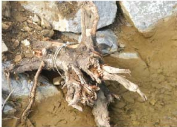
Mit Stahlseil (Erdanker) befestigter Wurzelstock, © ezb
