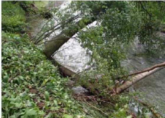
Sturzgefährdete Gehölze (z.B. wurfgefährdete Altbäume, unterspülte Bäume) sind gegebenenfalls zu fällen. Alternativ kann eine Sicherung mit Erdankern erfolgen, © ezb
