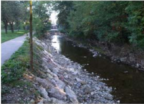
Durch Blockwurf sanierter Uferbereich an der Großen Tulln, © ezb
