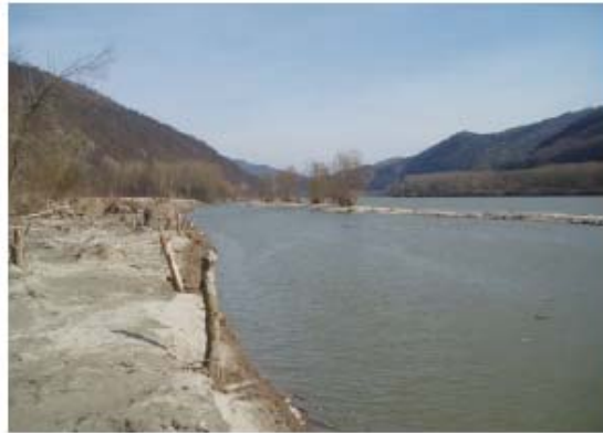
Wurzelstöcke an der Donau im Nebenarm Grimsing, unmittelbar nach Einbau, © ezb
