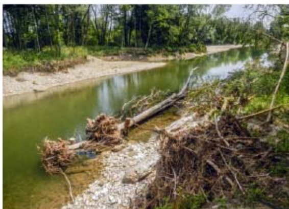
Mit Piloten befestigter Raubbaum an der Ybbs, © ezb
